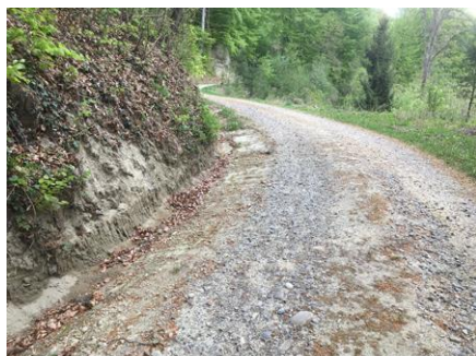
109: überall Entwässerung neu profiliert
