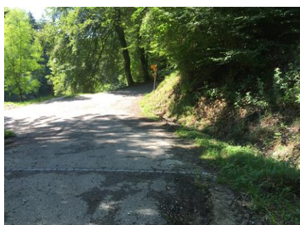
153: ca. km 0.680, Blickrichtung Süden
