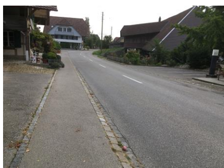
130: ca. km 0.400, Richtung Osten
