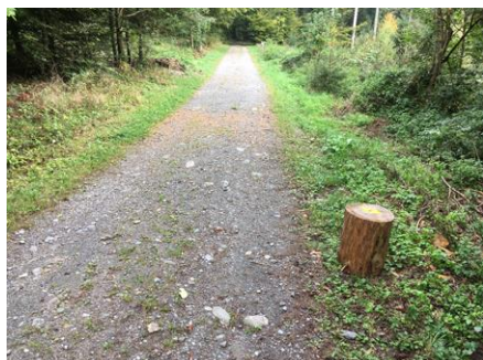
129: ca. km 0.100, Richtung Norden Rechts auf dem Pflöck die «mobile» Signalisation!
