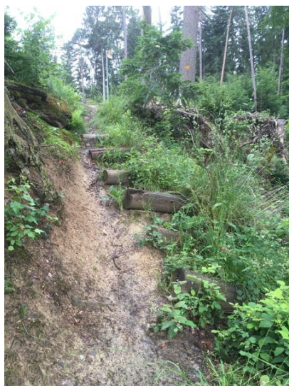
150: oberer Abschnitt mit alter Treppe
