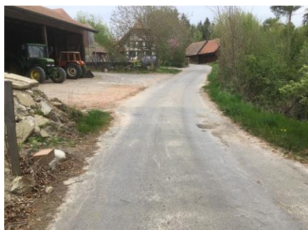
110: ca. km 0.000, Richtung Norden
