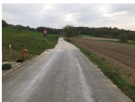
126: ca. km 0.000, Richtung Osten
