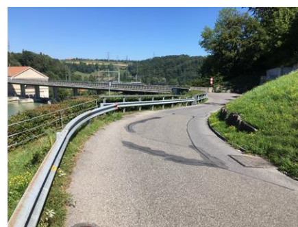
155: ca. km 0.470 Blickrichtung Westen
