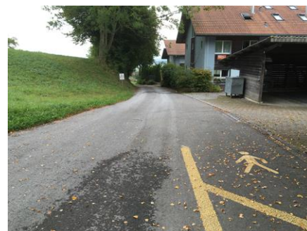
101: ca. km 0.000, Richtung Süden oberstes Stück mit Hartbelag
