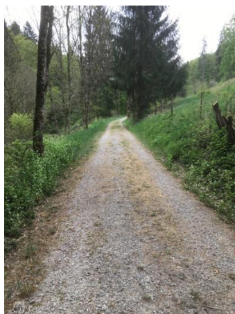
108: ca. km 0.050, Richtung Süden
