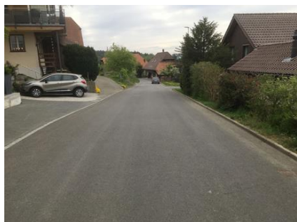
125: ca. km 0.270, Richtung Osten
