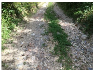
142: ca. km 0.120, Richtung Norden
