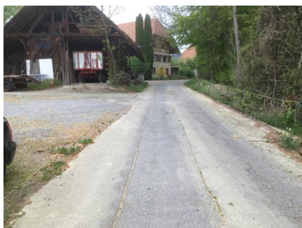
110: ca. km 0.150, Richtung Norden
