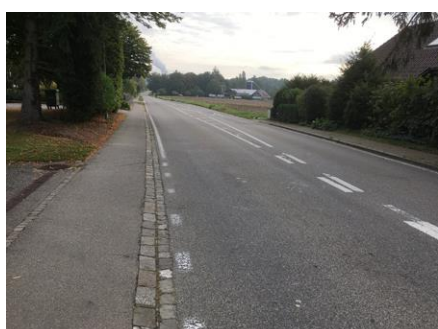
130: ca. km 0.800, Richtung Osten
