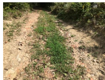
142: ca. km 0.100, Richtung Süden
