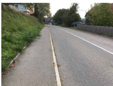
130: ca. km 0.100, Richtung Osten
