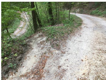
109: ca. km 0.100, Richtung Süden
