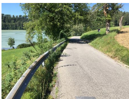
155: ca. km 0.380, Blickrichtung Westen
