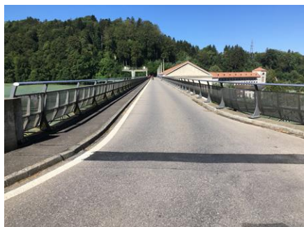
156: Trottoir beim Wasserkraftwerk, Blickrichtung Westen
