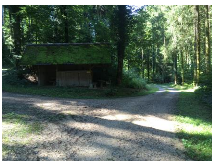
151: ca. km 0.500 Blickrichtung Süden
