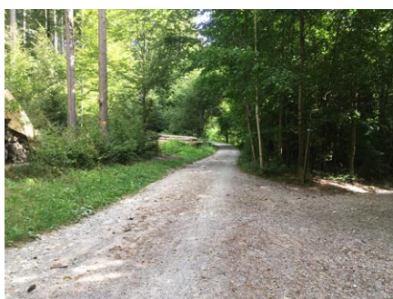
119: ca. km 0.050, Richtung Osten
