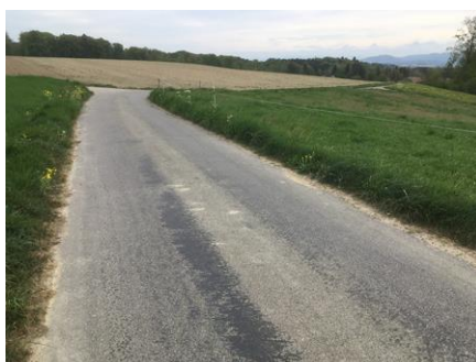
111: ca. km 0.400, Richtung Südost
