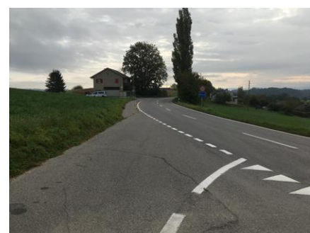
130: ca. km 0.000, Richtung Osten Einmündung in Kantonsstrasse
