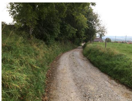
101: ca. km 0.150, Blickrichtung Süden
