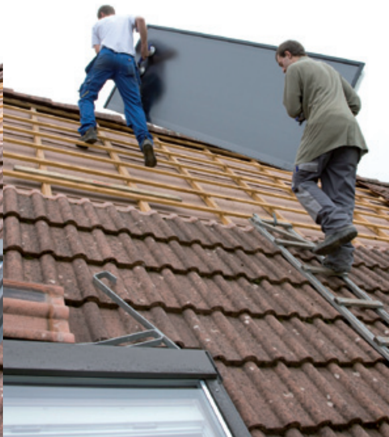
17.00 Uhr Nach nur einem Tag ist die beinahe wartungsfreie Solaranlage für Warmwasser mit dem Speicher montiert.
