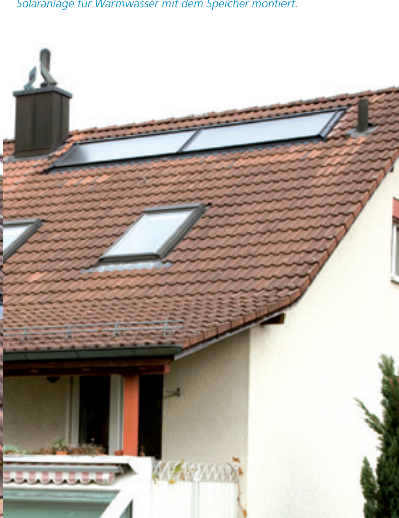
17.00 Uhr Nach nur einem Tag ist die beinahe wartungsfreie Solaranlage für Warmwasser mit dem Speicher montiert.
