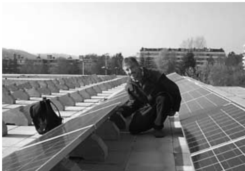
Andreas Matter auf dem Dach des Kappelenfeldschulhauses, als das zweite Solar-kraftwerk in Hinterkappelen noch nicht fertiggestellt war. (zvq)
